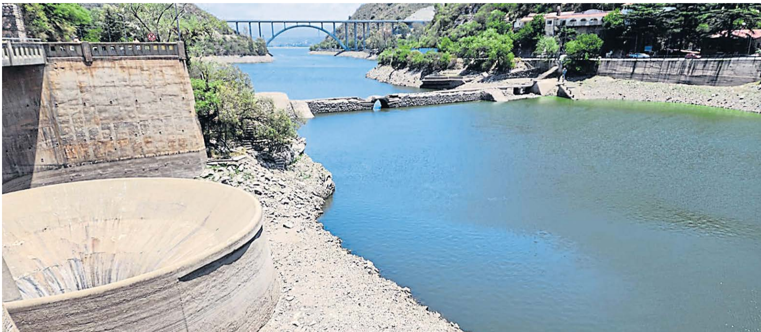
SOBREVIVIENTE. El antiguo paredón, aún visible, emerge de las aguas del embalse cuando el caudal del San Roque desciende.
