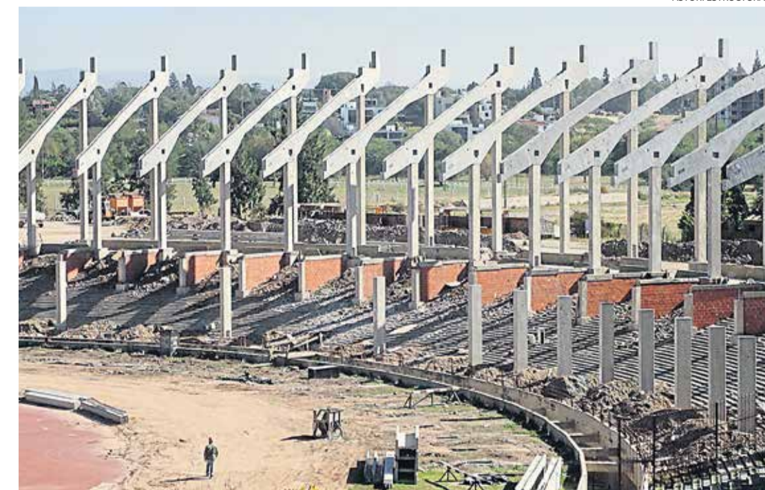
OPERATIVO. La Ingeniería Civil, con la ayuda de la tecnología más avanzada, posibilitó dar la mejor respuesta técnica y económica a una obra de gran magnitud.
