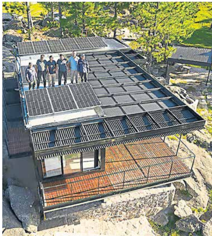
FOTOVOLTAICA. La energía solar es la que menos afecta el entorno en el que vivimos y la que menos huella de carbono deja.
