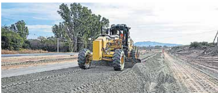
TRABAJOS. Este concepto mejorará la seguridad vial de la zona.
