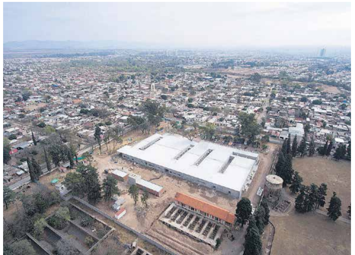
El nuevo Hospital Zona Suroeste de Córdoba tiene una superficie 5.200 metros cuadrados y se desarrolla en dos ejes paralelos: uno público y otro técnico.
