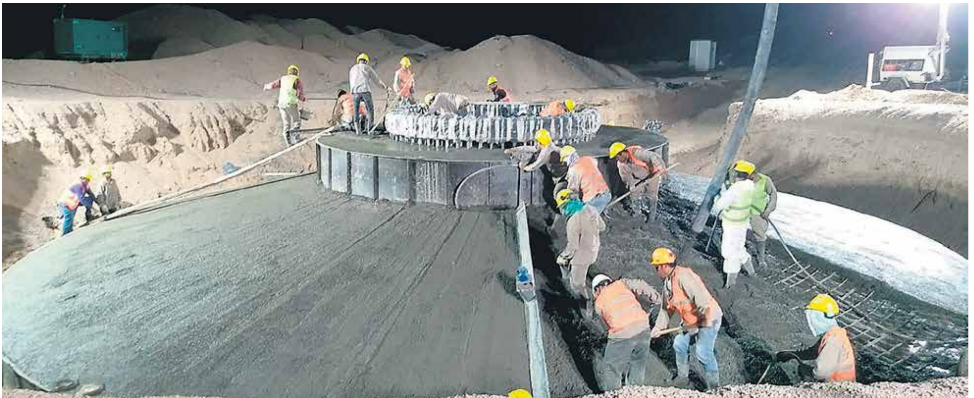
Las estructuras pueden sufrir deterioros por múltiples factores.
