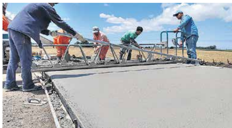
Actualmente, se dispone de mucha tecnología que se adapta a condiciones extremas de colocación.
