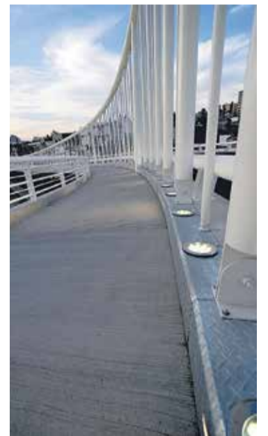
El puente tiene una extensión total de unos 230 metros y presenta un desarrollo curvo con un radio de giro de unos 46 metros.
