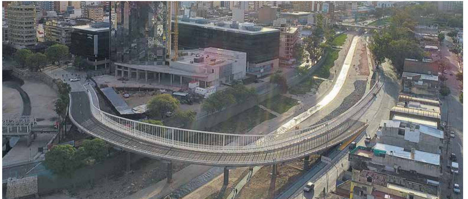
La estructura principal posee 11 tramos de longitud variable entre 15 y 19 metros.
