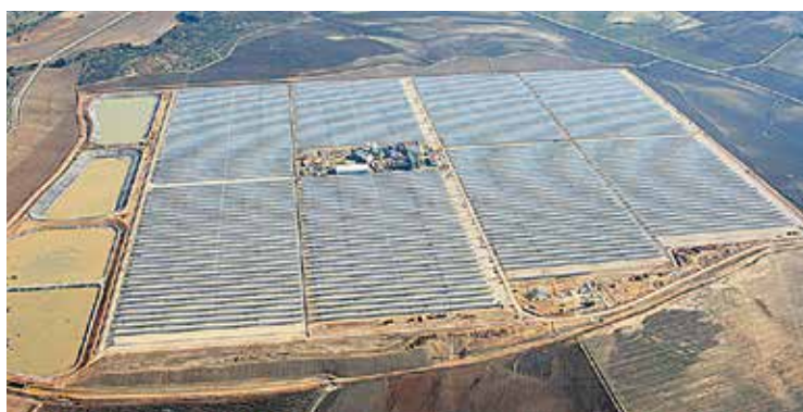
La Planta Termosolar de Morón de la Frontera (Sevilla) se destaca por tener concentradores cilíndricos y parabólicos.
