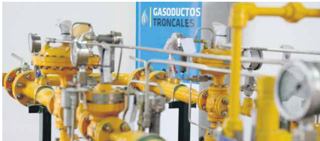
Se habilitaron dos plantas reguladoras de presión y los ramales de alimentación.
